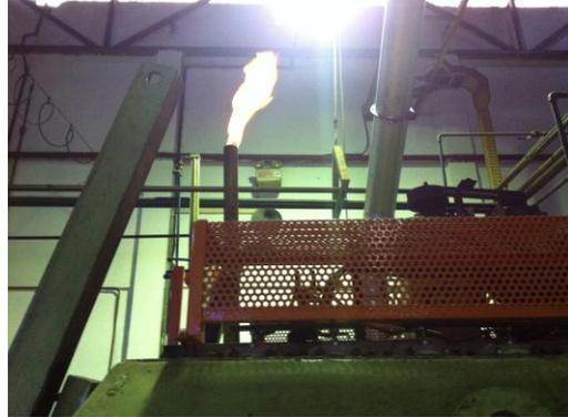
Figura 12 (esq): Detalhe da tampa de explosão e saída lateral de gases na câmara de resfriamento de forno SQ. (Itaraí Metalurgia)
