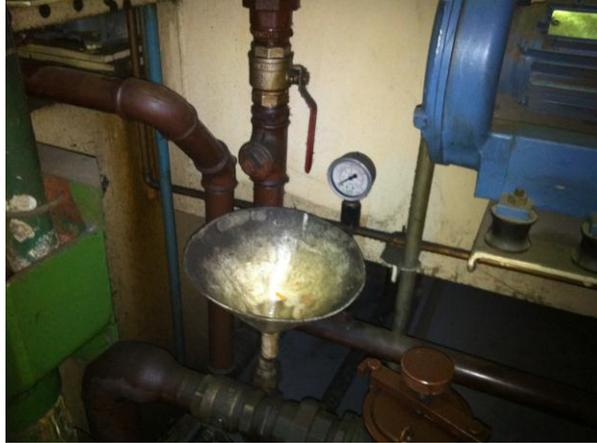
Figura 14: Detalhe do sistema de tubo sifão na lateral do equipamento SQ. (Itaraí Metalurgia)
