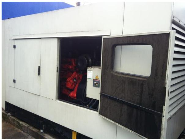
Figura 08: Detalhe de gerador a diesel para manter equipamentos em funcionamento em caso de falta de energia elétrica (Itaraí Metalurgia)
