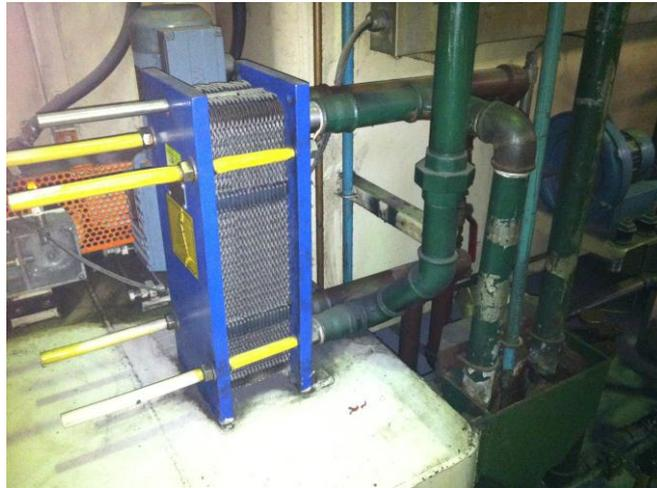
Figura 15: Detalhe do trocador de calor e das tubulações de água de resfriamento na lateral do forno (Itaraí Metalurgia)
